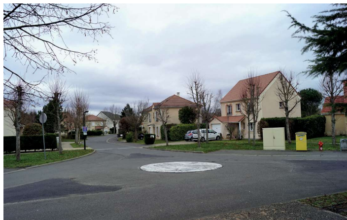
Remplacement du giratoire abîmé et dangereux par un marquage au sol
