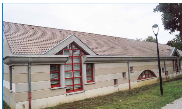
Réfection complète de la toiture école Anne Frank
